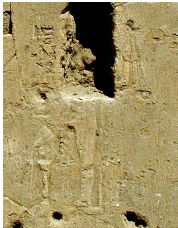
Fig. 16. Graffiti d'Amon-qui-écoute-prières (mur sud).
