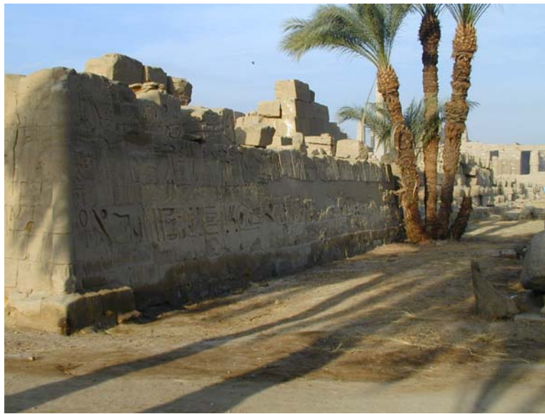
Fig. 3. Vue générale du mur nord (depuis l'angle nord-est)
